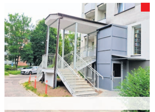
Wymiana windy osobowej wraz z wybudowaniem dodatkowego przystanku na poziomie ciągu pieszo-jezdnego w budynkach przy ul. Łętowskiego 12, Radockiego 86, 104 i 130.
